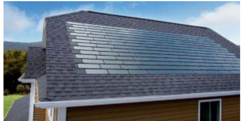
PV σε οροφές
